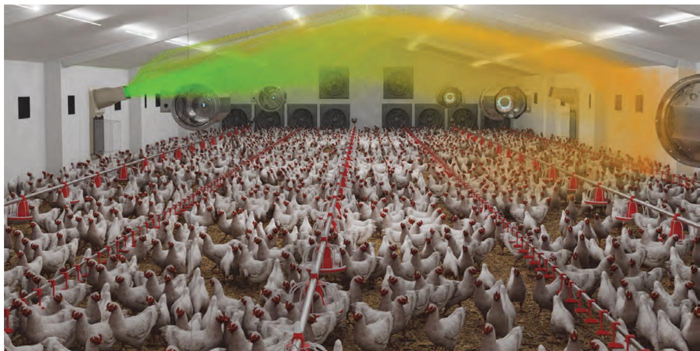
● С помощью горизонтальных направляющих движение воздушного потока настраивается параллельно кровле в направлении конька .
